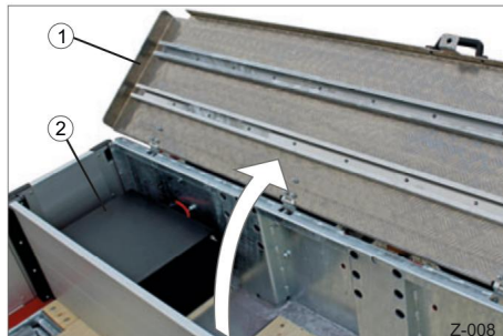
Abb. 12 Armoires à batteries
