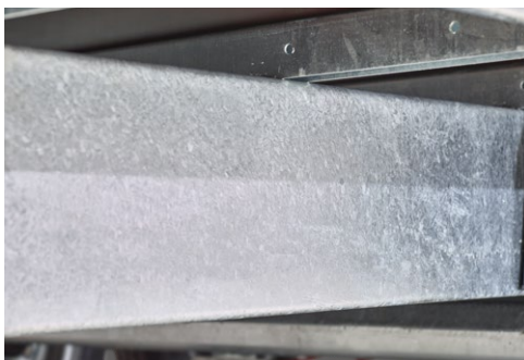
Frame en chassis zijn in het dompelbad thermisch verzinkt
