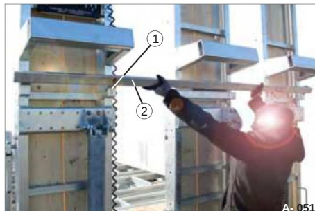
Afbeelding 73 Dwarsbalk verwijderen
