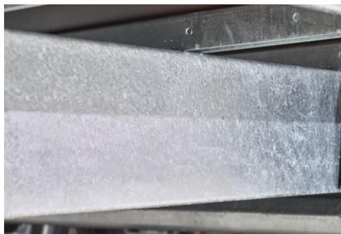
Cadre et châssis galvanisés à chaud par immersion
