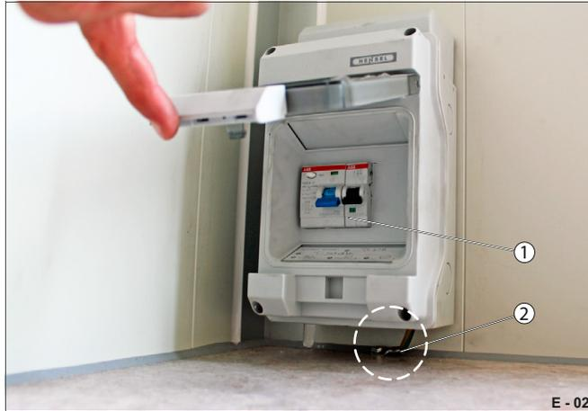
**Fig. 24 Boîtier de distribution électrique**
